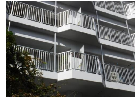
施工後(バルコニー)
