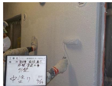
外壁塗装工事
