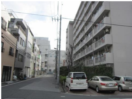
施工前(東棟バルコニー)
