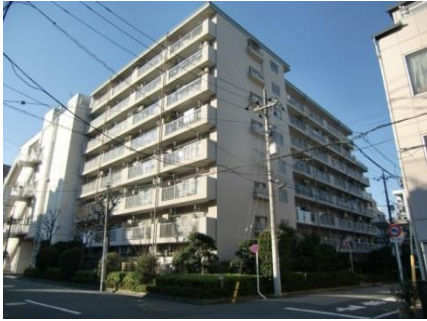
施工前(南・東棟)
