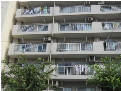
施工前(南棟バルコニー)
