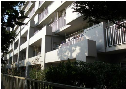
アウトフレーム工法施工事例
