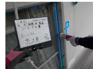
シーリング工事
