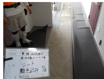
長尺シート貼り替え工事
