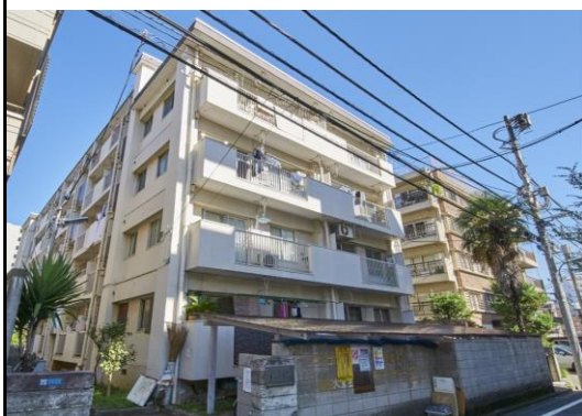
道路際ブロック塀【撤去前】
