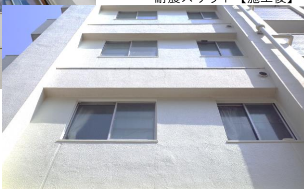
耐震スリット【施工後】
