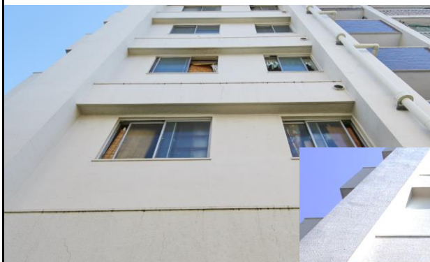
耐震スリット【施工前】
