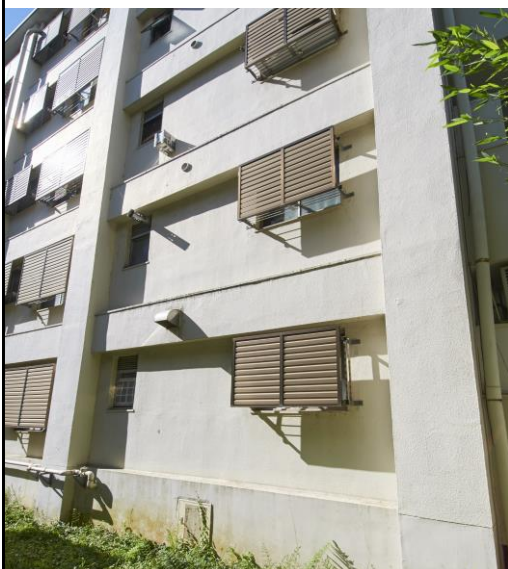
耐震増し打ち壁【施工前】
