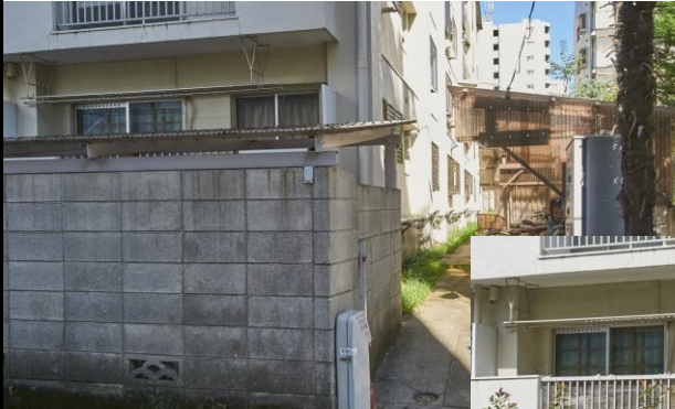
道路際ブロック塀【撤去前】
