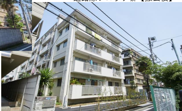
道路際ブロック塀【撤去後】
