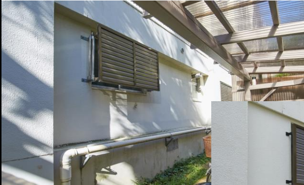
耐震増し打ち壁【施工前】
