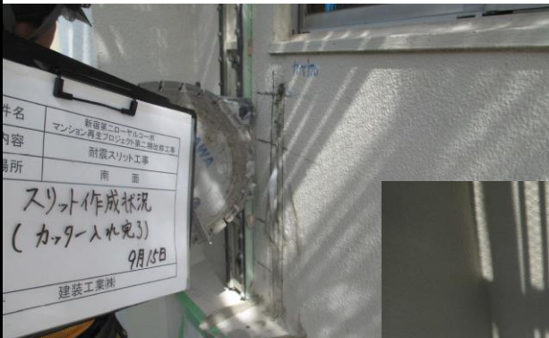
耐震スリット【施工中】
