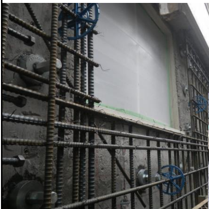
耐震増し打ち壁【施工中】
