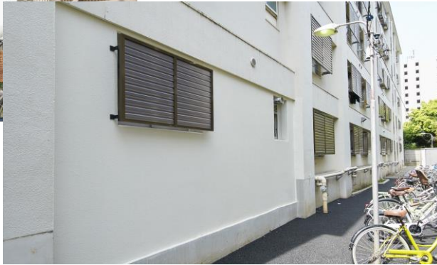
耐震増し打ち壁【施工後】
