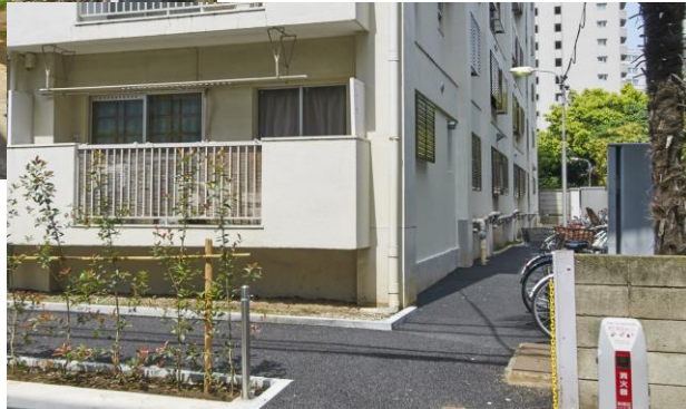
道路際ブロック塀【撤去後】
