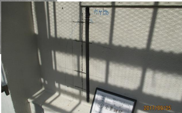
耐震スリット【施工中】
