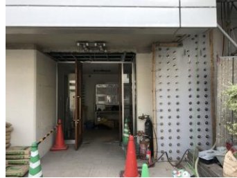
主棟と副棟の結合(エントランス)
