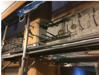
副棟梁型の増し打ちと結合アンカー
