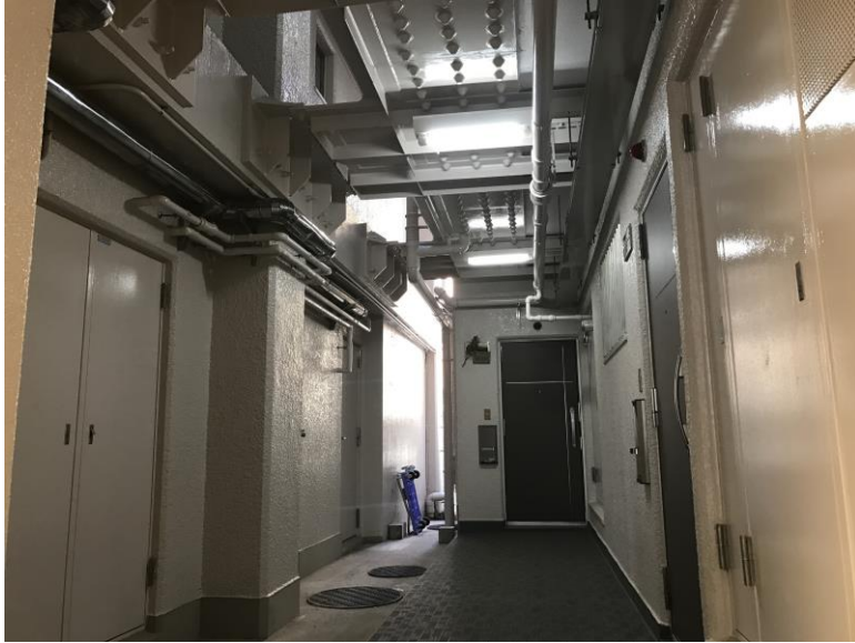
1階主棟副棟結合部
