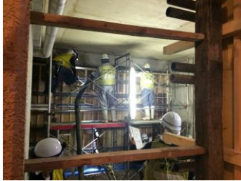
副棟旧受水槽室耐震壁増し打ち
