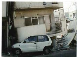
阪神・淡路大震災での建物被災状況(RC造、SRC造)
