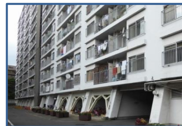
耐震改修事例 (Fマンション) 枠付き鉄骨ブレース補強等を実施
