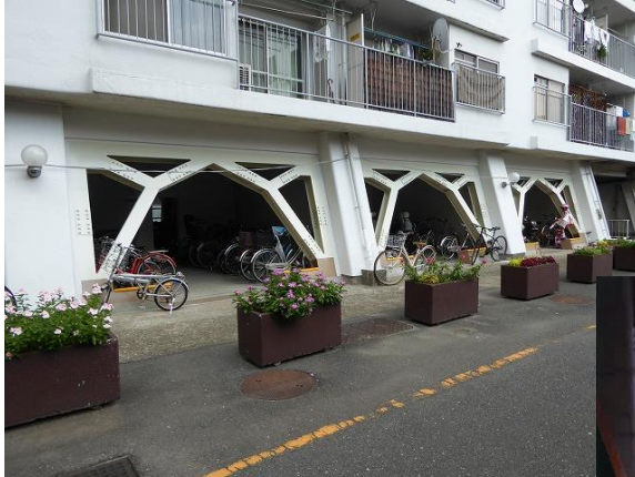
枠付き鉄骨ブレース増設(1階) (マンサード型ブレース)
