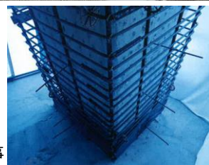
柱配筋工事
